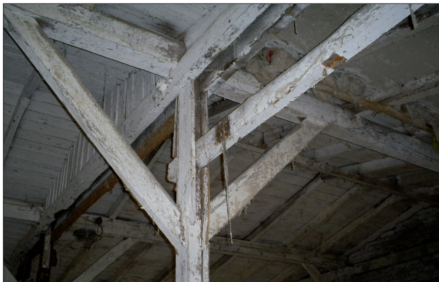
Oryginalna konstrukcja nośna baraku, 2010 rok, fot. J. Bogdanowicz
