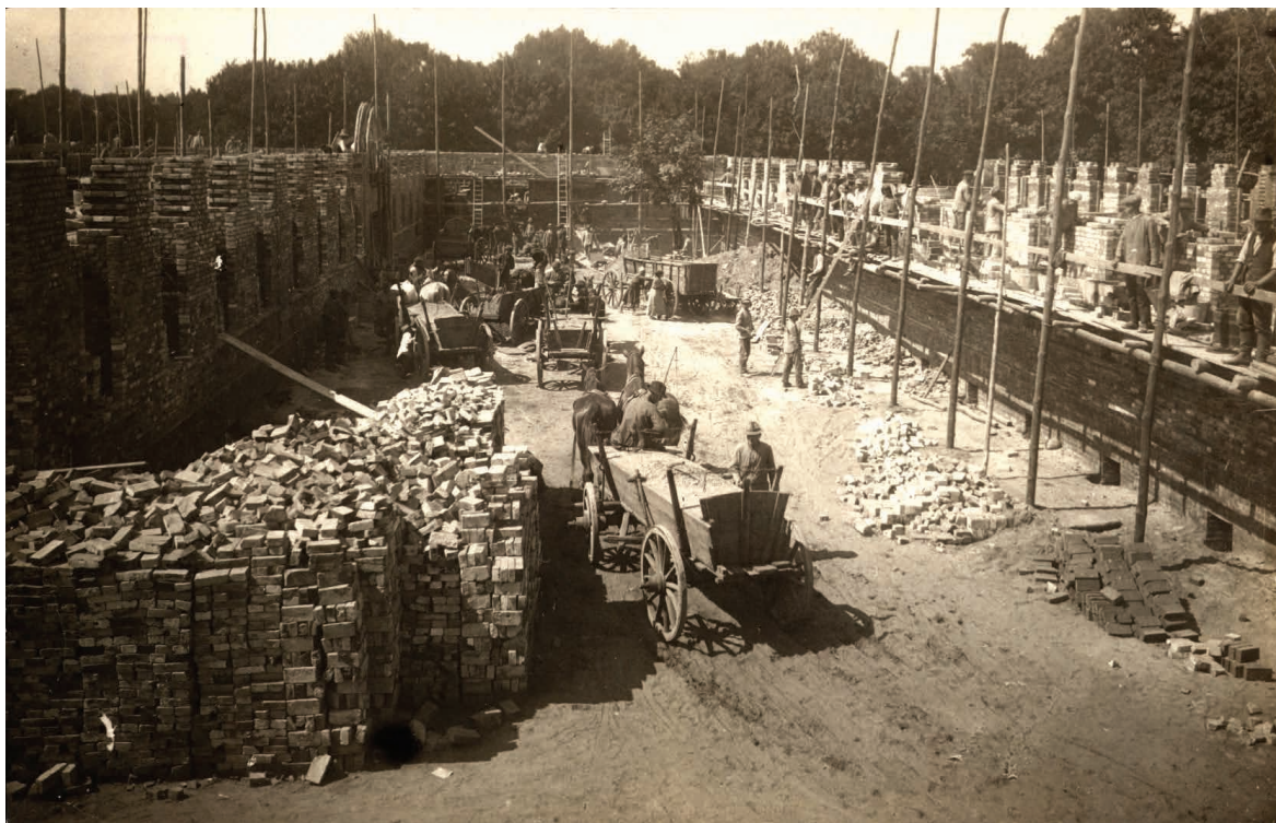
20. Budowa koszar 55 Pułku Piechoty przy ul. Cmentarnej, 1925 r.
