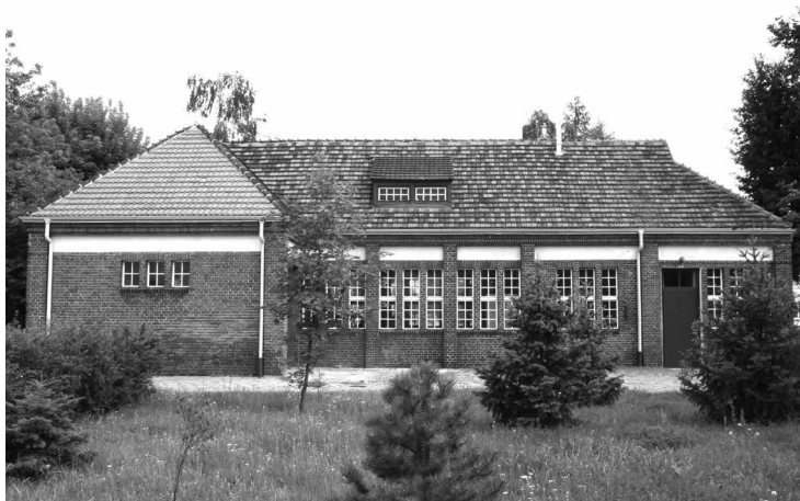
15. Widok budynku mechanicznej oczyszczalni ścieków po rozbudowie o trzyosiowy człon (z prawej), 2007 r.
