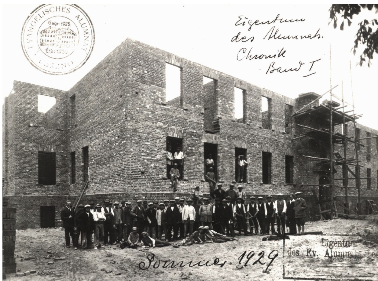
16. Budowa Alumnatu Ewangelickiego (ob. budynek komendy Policji przy ul. Teodora Korcza), 1929 r.
