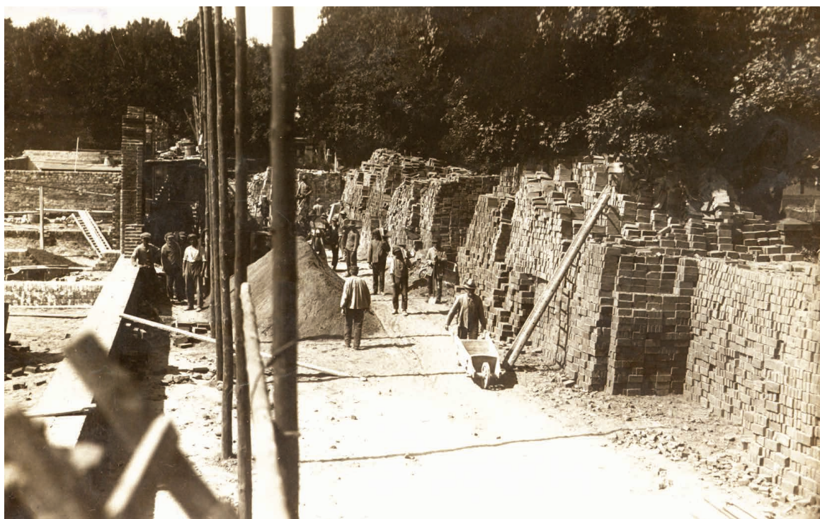
23. Budowa koszar 55 Pułku Piechoty przy ul. Cmentarnej, 1925 r.
