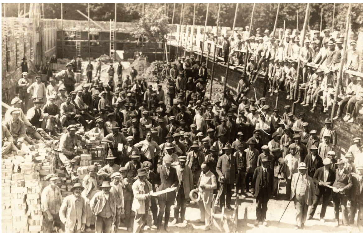
21. Budowa koszar 55 Pułku Piechoty przy ul. Cmentarnej, 1925 r.
