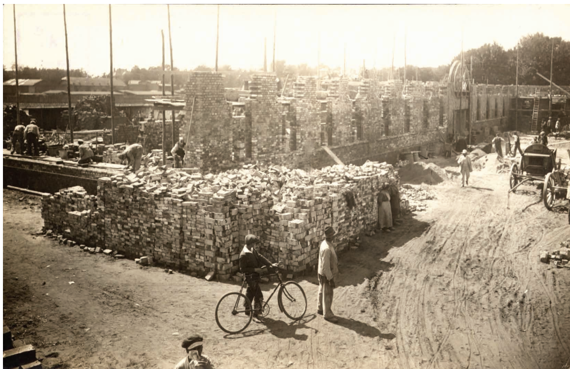
22. Budowa koszar 55 Pułku Piechoty przy ul. Cmentarnej, 1925 r.
