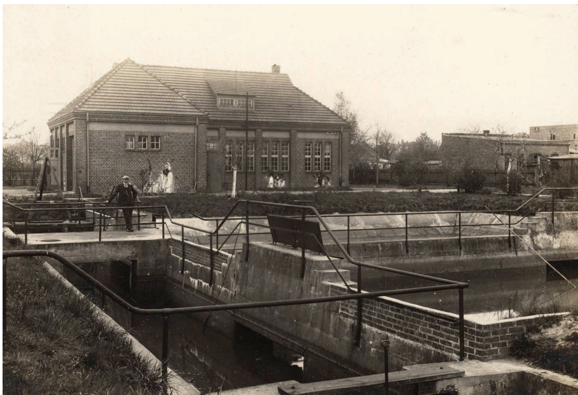
26. Widok piaskownika, zbiorników retencyjnych oraz oczyszczalni ścieków ze stacją pomp, przed rozbudową, ok. 1925 r.
