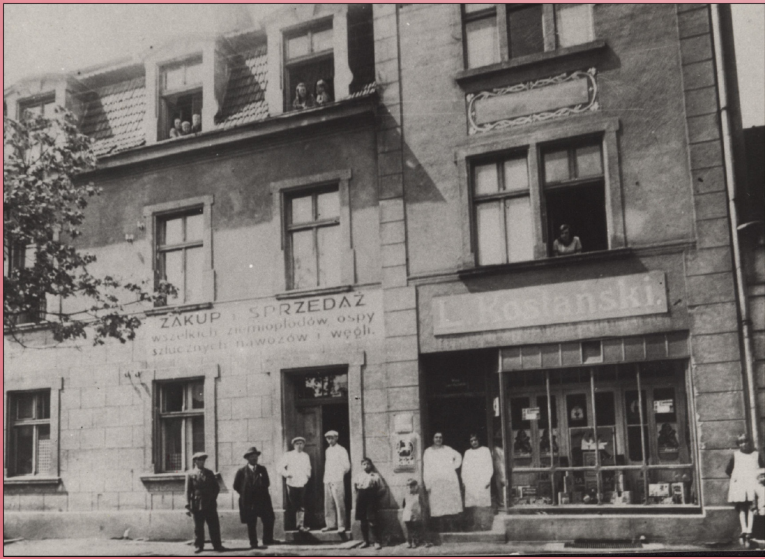
Dom, w którym mieściła się komenda Obwodu Kościan [APL, Jerzy Zielonka – spuścizna (dziennikarz „Panoramy Leszczyńskiej”), sygn. 1902]
